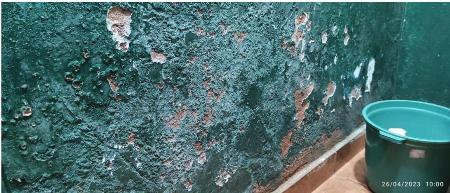
PAREDE DO BANHEIRO FEMININO COM PINTURA DETERIORADA E SINAIS DE INFILTRAÇÃO... LIXEIRA SEM TAMPA.
